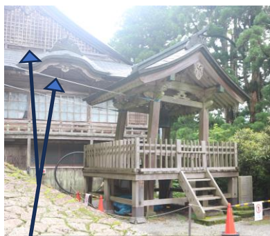
解体前の「釣鐘堂」と 「社務所」の唐破風・木連格子
