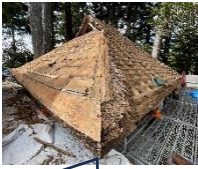
解体途中の屋根
